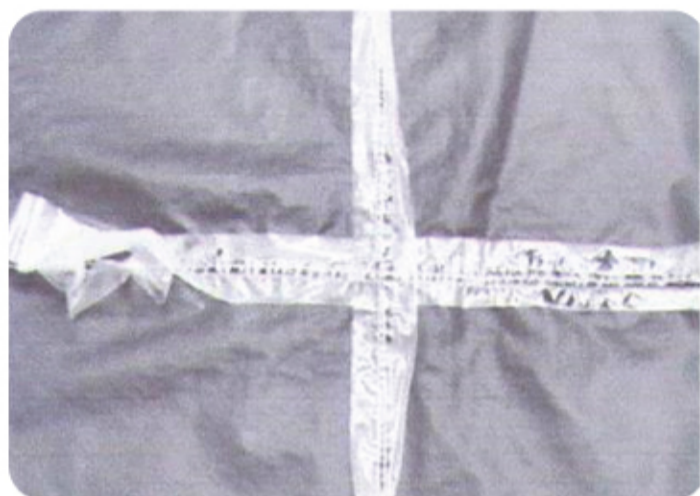
герметизация с нарушением технологии
